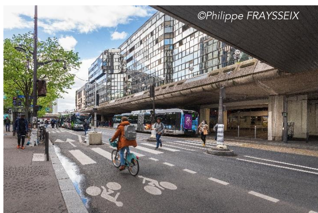
Actuelle façade de la Gare de Lyon côté rue de Bercy
